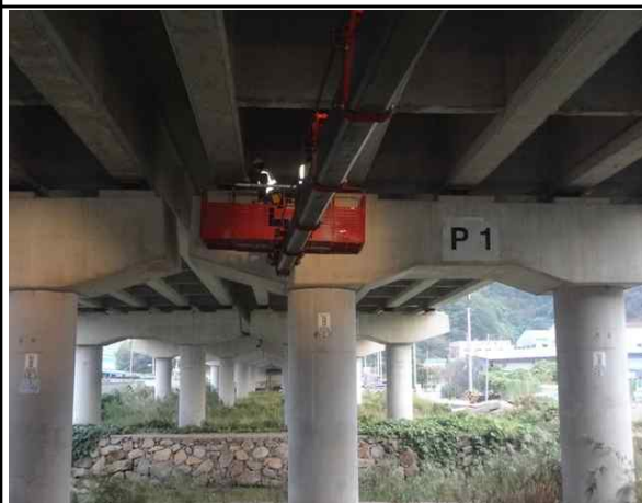
고소점검차를 이용한 외관조사
