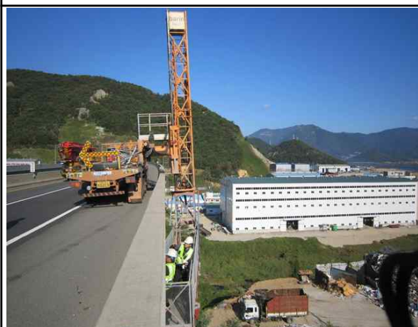
교량점검차를 이용한 외관조사
