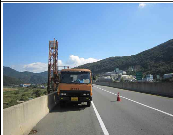
교량점검차를 이용한 외관조사
